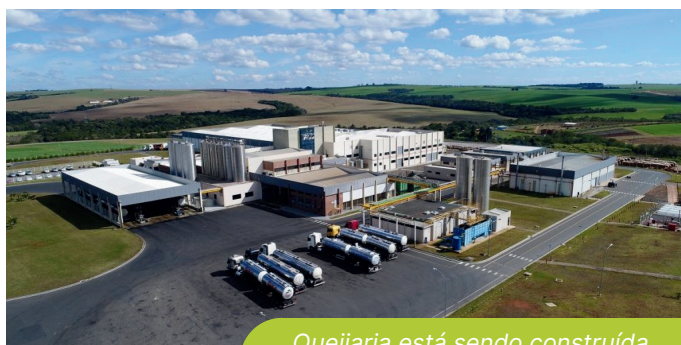
Queijaria está sendo construída junto à UBL de Ponta Grossa
