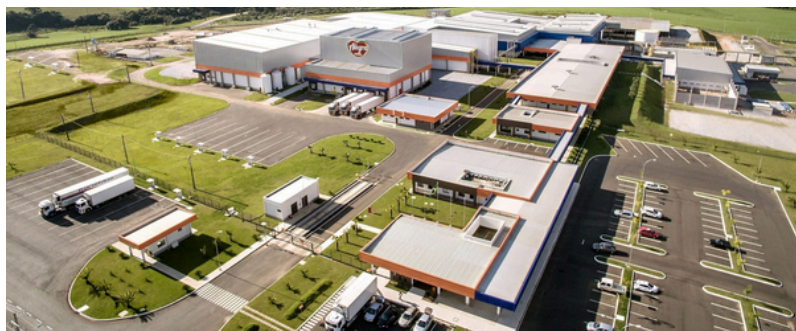
A participação da Capal no Sistema Aurora Coop conecta a produção dos cooperados à estrutura industrial da cadeia de carne suína, contribuindo para dar destino à produção e segurança ao trabalho realizado nas granjas, inclusive nas unidades que atuam em etapas específicas, como a UPL.
